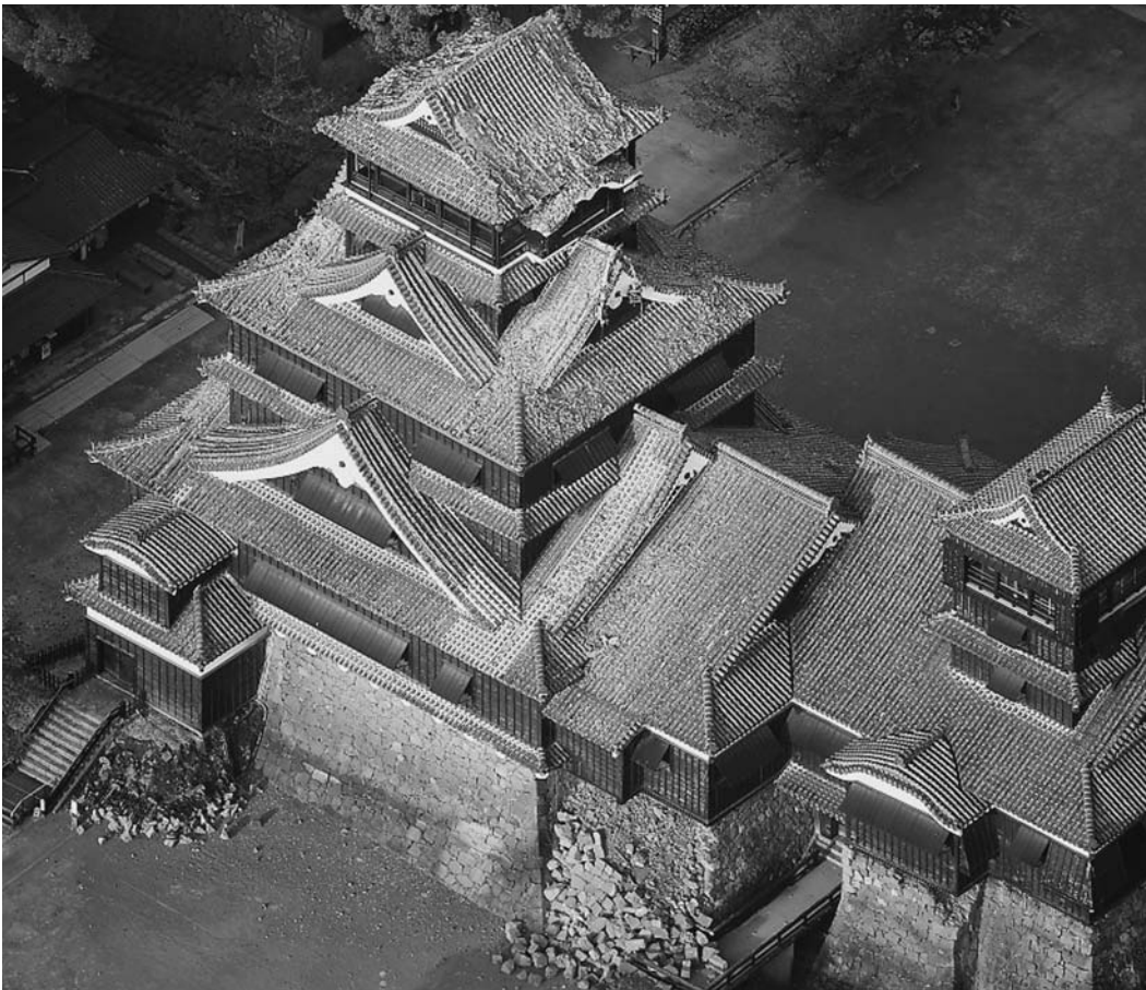
地震で屋根瓦が落ち石垣が崩壊した熊本城（国の重要文化財）
